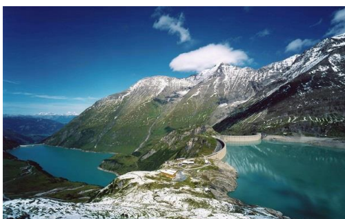
Figure X : bassins haut et bas de la STEP de Limberg II, Autriche. Source: VoithHydro.
